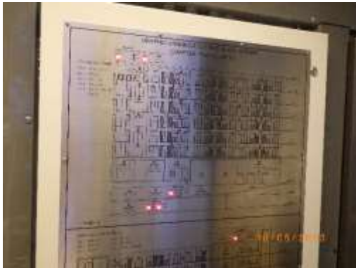
แผงควบคุม ระบบแจ้งเหตุอัคคีภัย (Fire Alarm Control Panel: FC)
