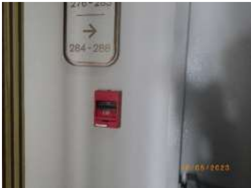
ปุ่มกดแจ้งสัญญาณอัคคีภัย (Fire Alarm Manual Station)
